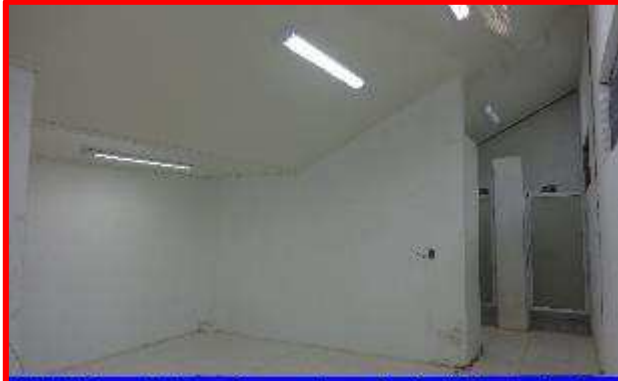
Vista interna del área de camerinos - Gradería Oeste, donde se aprecia la ejecución de las actividades de pisos, lámparas, puertas de aluminio y lámina acrílica rugosa.
