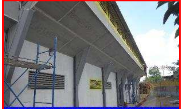
Fachada costado Oeste de la cancha de Voleibol techado, donde se observa la ejecución de la etapa de ventanas, forro de durock, pintura.
